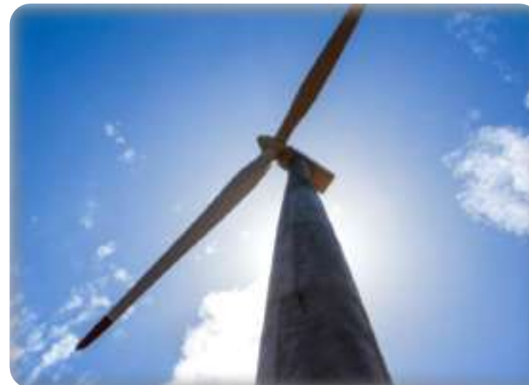
Aerogerador em Areia Branca - RN
